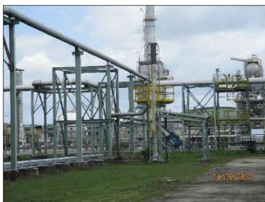
ระบบ Low low pressure flare (LLP Flare)
