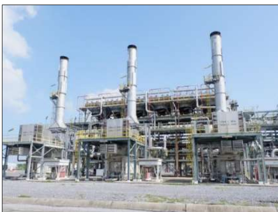
รูปที่ 2-6 เครื่องกังหันก๊าซที่ใช้ขับเคลื่อนเครื่องเพิ่มความดันก๊าซ (Gas Turbine Compressor)
