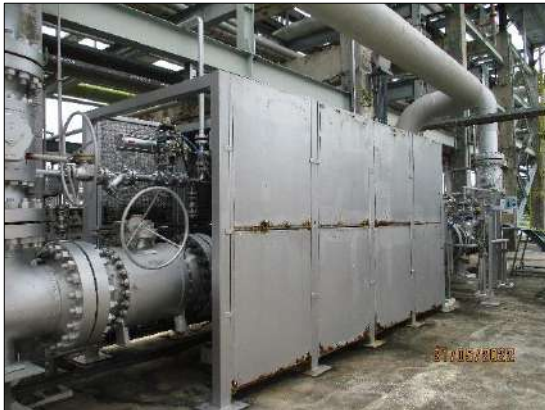
รูปที่ 2-12 การติดตั้งอุปกรณ์ป้องกันเสียงและดูดซับเสียง
