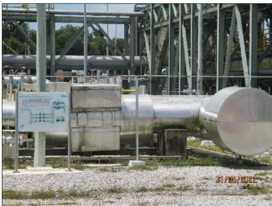
รูปที่ 2-13 ติดตั้งตัวปรับลดเสียง และฉนวนดูดซับเสียง ห่อหุ้มที่วาล์ว เพื่อให้ระดับเสียงอยู่ในระดับมาตรฐาน
