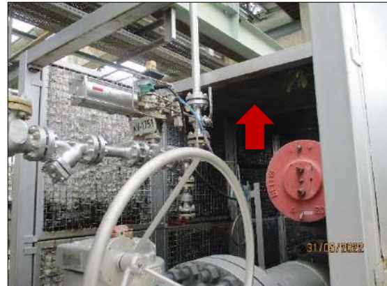
รูปที่ 2-12 การติดตั้งอุปกรณ์ป้องกันเสียงและดูดซับเสียง
