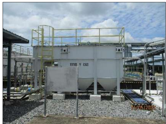
รูปที่ 2-18 หน่วย Flotation unit เพื่อให้น้ำมันที่เหลืออกแยกตัวออกจากน้ำ
