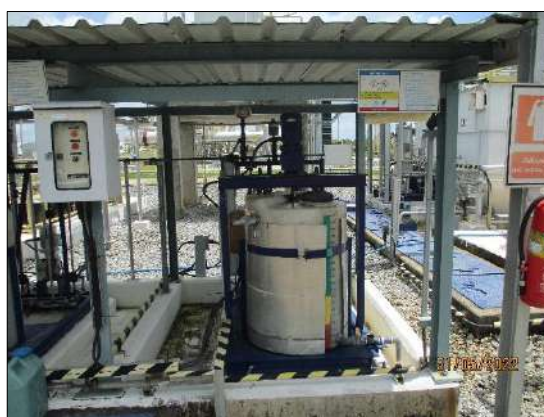
รูปที่ 2-24 การเติมสารเคมี Flotation agent เพื่อเพิ่มประสิทธิภาพในการแยกน้ำมันที่เหลื ออกจากน้ำ
