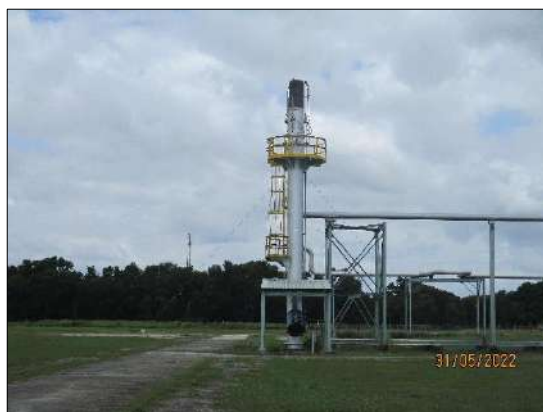
ระบบ Low pressure flare (LP Flare)
