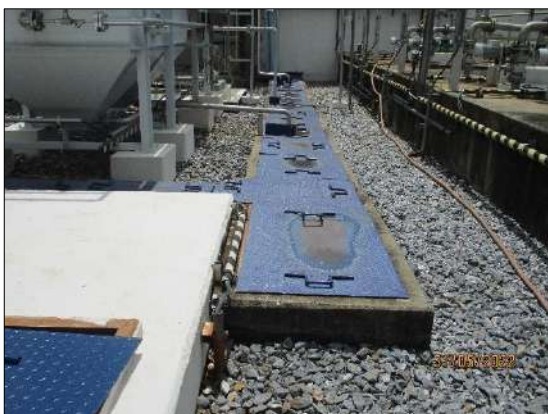
Recovered oil sump สำหรับเก็บรวบรวมน้ำมันที่แยก ออกจาก CPI และ Flotation unit
