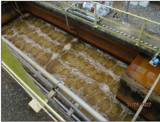
รูปที่ 2-26 บ่อรับน้ำเสียที่มีการปนเปื้อน (Contaminated Water Receiving Sump)
