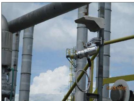
รูปที่ 2-57 ระบบตรวจจับก๊าซรั่ว
